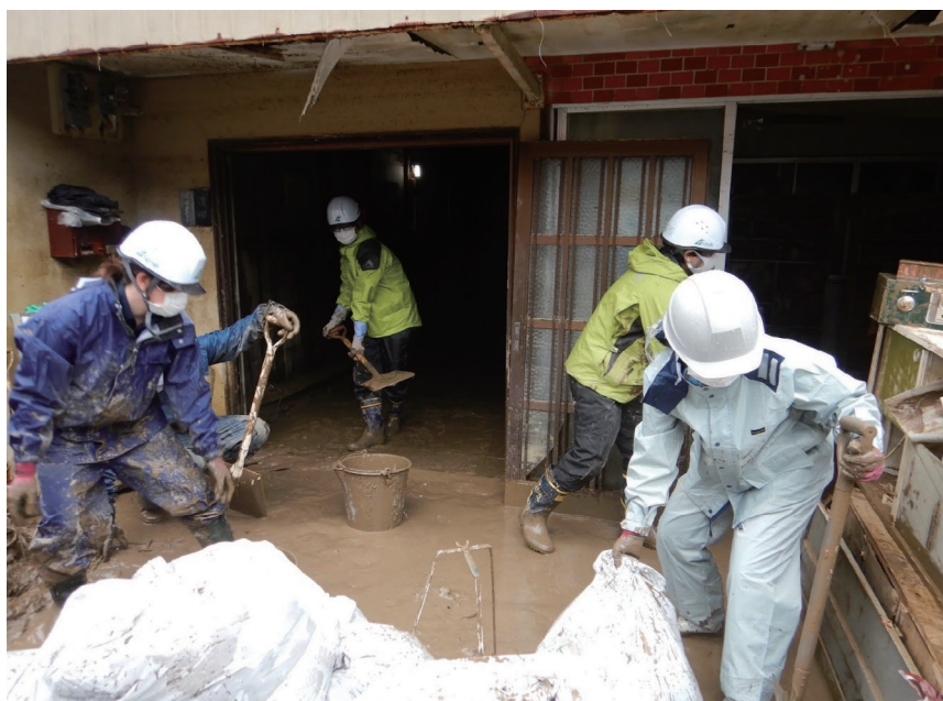
人吉球磨水害における復旧作業の様子
